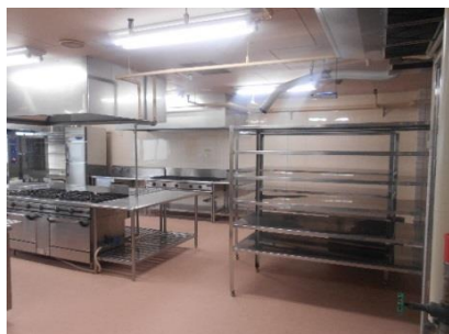
ピンクを基調とした床と壁で、明るい厨房へと生まれ変わりました。
